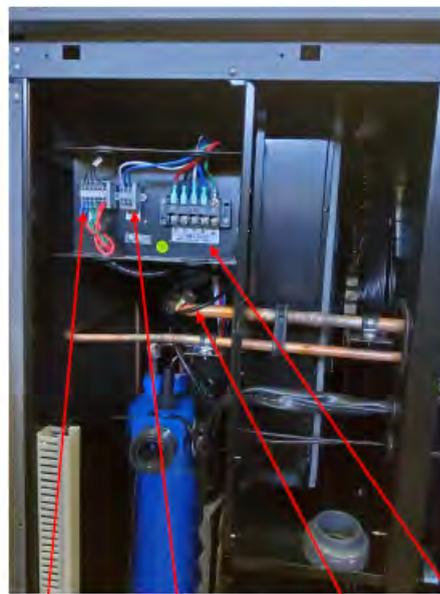
Fern EIN/AUS Kontakt 5+6, pot. frei. Zum Anschluss an bauseitige Filterpumpensteuerung
