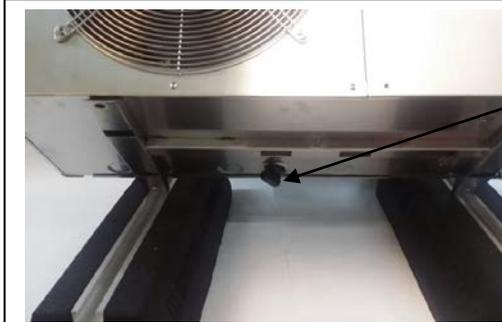
Falls gewünscht Drainage am Boden anbringen und Kondensat entsprechend ableiten. In der Regel genügt eine Versickerung in der Wiese ohne Drainage.
