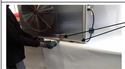
Um den Elektroanschluss durch ein externes Kabel herzustellen, (nur durch Fachkraft) lösen Sie bitte die zwei Schrauben im Frontblech und ziehen dieses nach unten und vorne weg.
