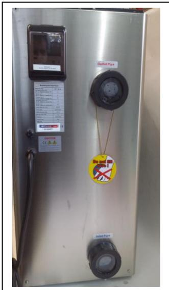
Rohrleitungen d 50 an die Anschlüsse mittels PVC Kleber anbringen.
